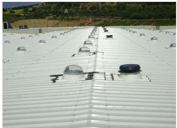
Греция, Чалкидакис, Крит, крыша склада (Solatube® & Solar Star®)
