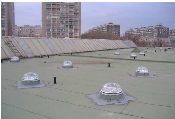
Венгрия, Кнор-Бремс, крыша гипермаркета (Solatube® Daylighting Systems)
